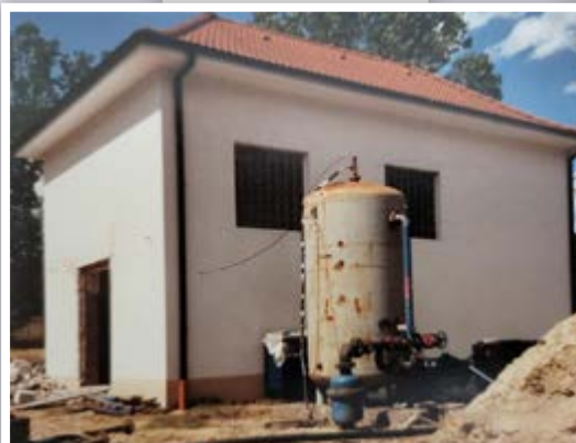
Zur Gewährleistung von Trinkwasser: Während der Sanierungsarbeiten 2001 vom komplett entkernten Wasserwerk Wesenberg wurde außerhalb zur Aufbereitung des Wassers ein provisorischer Filter aufgestellt. Foto: WZV
