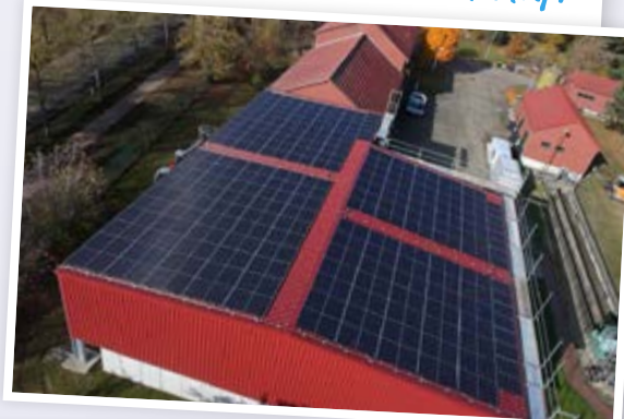
Auf der Kläranlage Mirow ist die großflächige Solaranlage eine gute Investition in die Zukunft.
