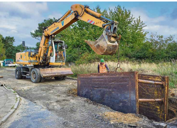
Mitte diesen Jahres soll die Erneuerung der Kanalisation in Wesenberg am Fischersteig beendet sein.
