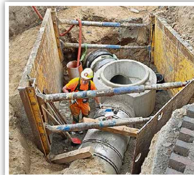
Mannshöhe Leitungen und Schächte für das Regenwasser in Bad Doberan.
