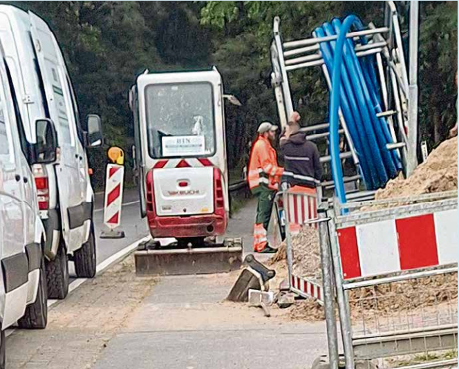
Die Hauptleitung PE 110 in der Retzower Straße in Mirow ist eingezogen.
