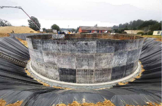
Die Wand des Belebungsbeckens hat nun die endgültige Höhe von drei Metern erreicht.
