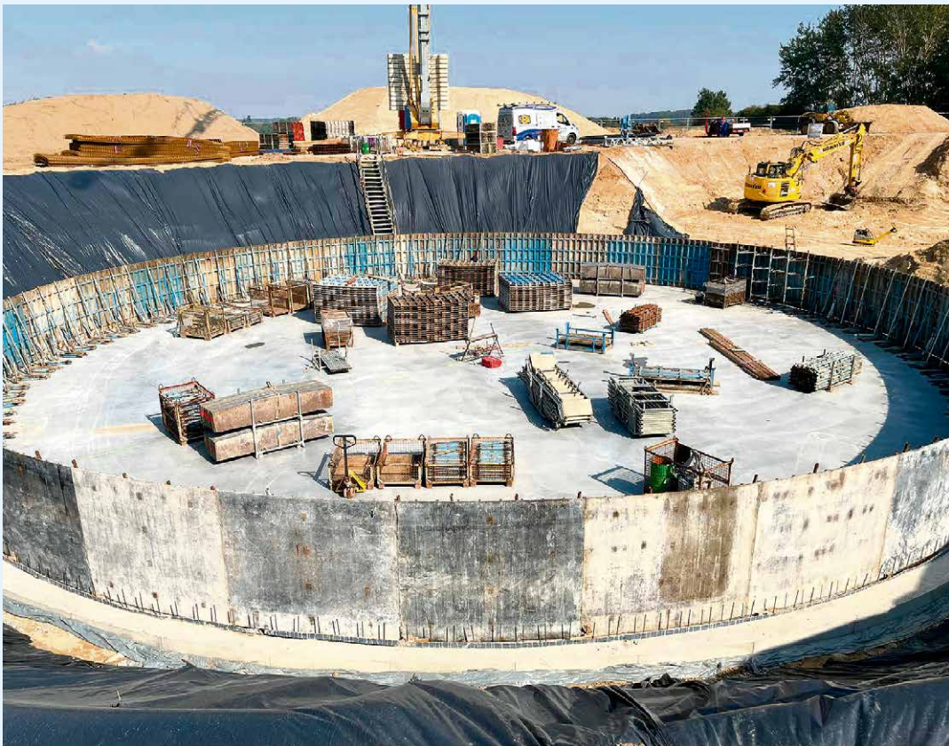
Die erste Reihe der Schalung steht.
