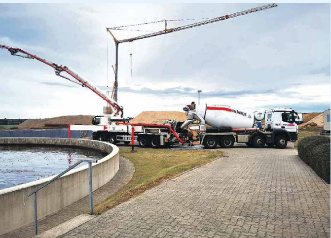
Während des laufenden Betriebs der Kläranlage rollen die Betonmischer an.
