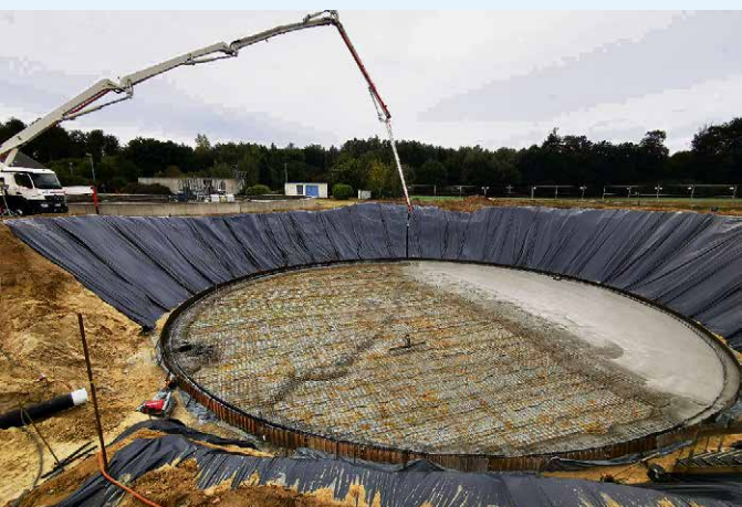
Die Sohle des Belebungsbeckens wird gegossen.
