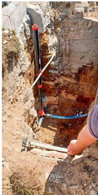
In Rödlin, Wesenberg und Peckatel (v. l.) befinden sich drei der aktuellen Baustellen des WZV.
